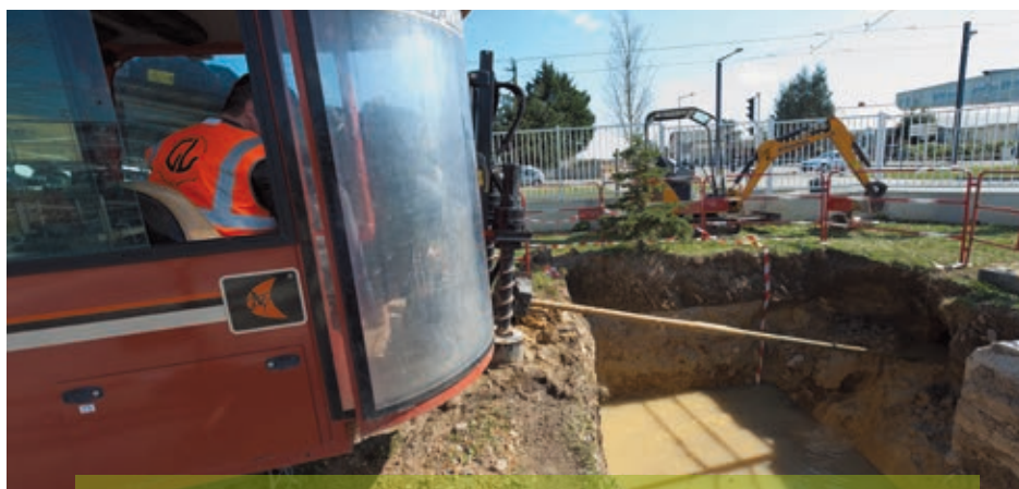
Le forage du tunnel pour acheminer les câbles haute-tension a nécessité deux semaines d'intervention.
