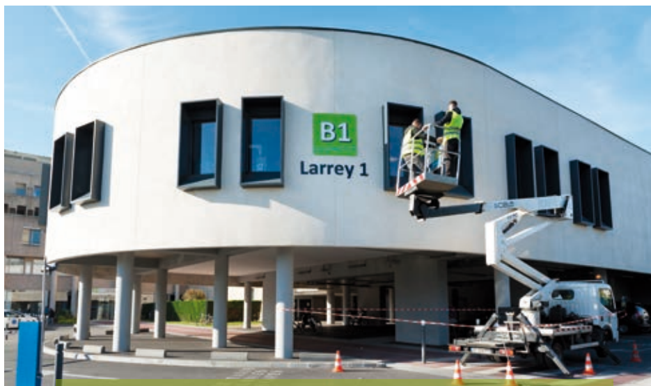
L'entreprise Elite et Greleg s'est chargée de la fabrication et de la pose de cette nouvelle signalétique.
