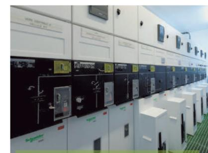
En cas de coupure électrique, ces cellules haute tension de 20 000 volts servent à réalimenter électriquement le CHU.
